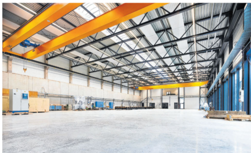
Die neue Montagehalle, das sogenannte Technikum II, wurde als Stahlbau realisiert.
